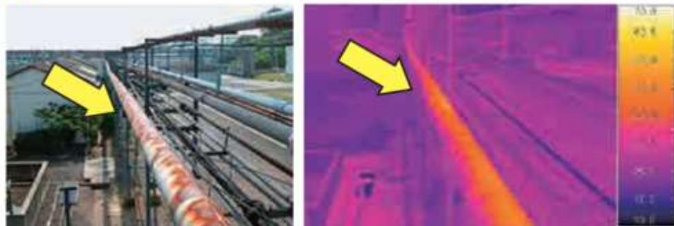
■ 増し保温工法 施工後 表面温度：34.1℃ 放散熱量：66w/m
